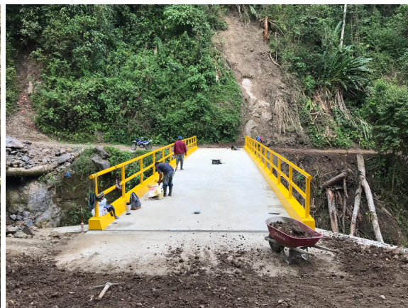
4. Acceso Puente y pintado
