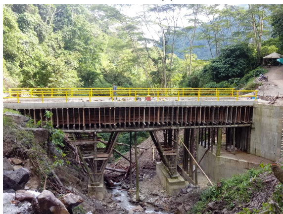
4. Obras contra crecientes
